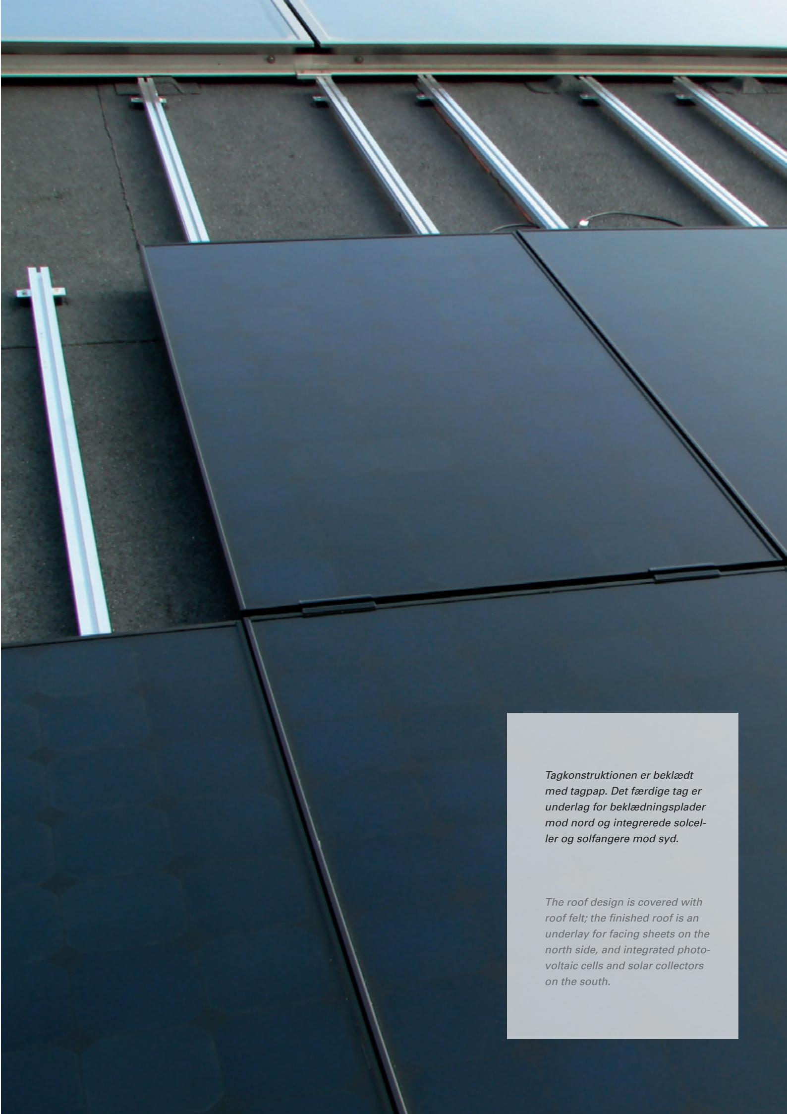
*Tagkonstruktionen er beklædt med tagpap. Det færdige tag er underlag for beklædningsplader mod nord og integrererede solcelle- og solfangere mod syd.*
